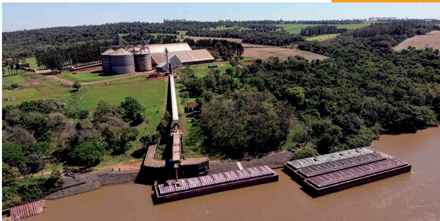
Silos y puerto de embarque en Hohenau. Fuente: Cooperativa Colonias Unidas.
