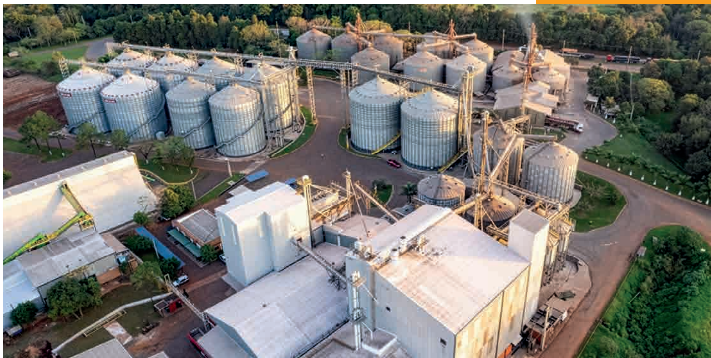
Vista aérea de los silos de la cooperativa Colonias Unidas. Fuente: Cooperativa Colonias Unidas.
