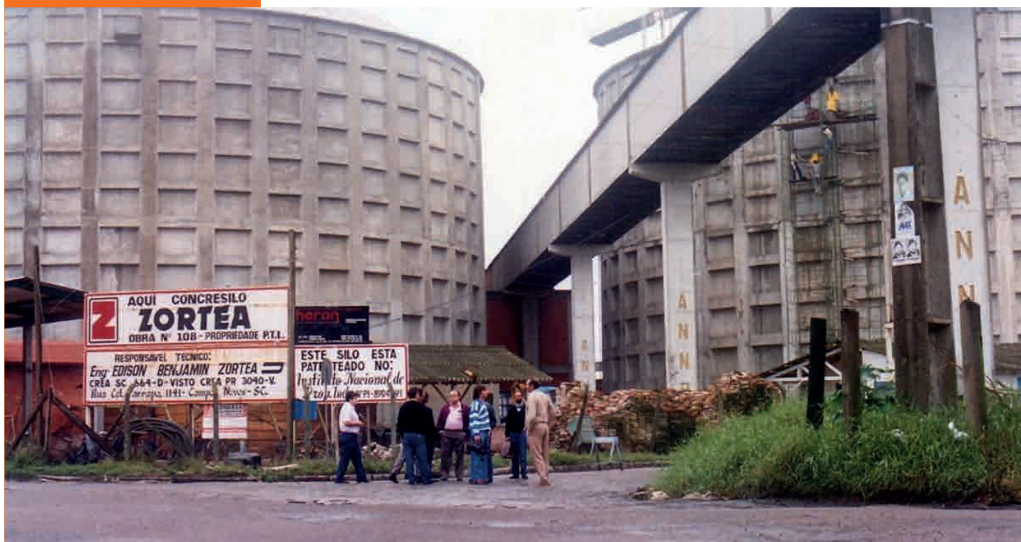
Construcción de silos suplementarios en Paranaguá, década de 1980. Fuente: archivo CAPECO.
